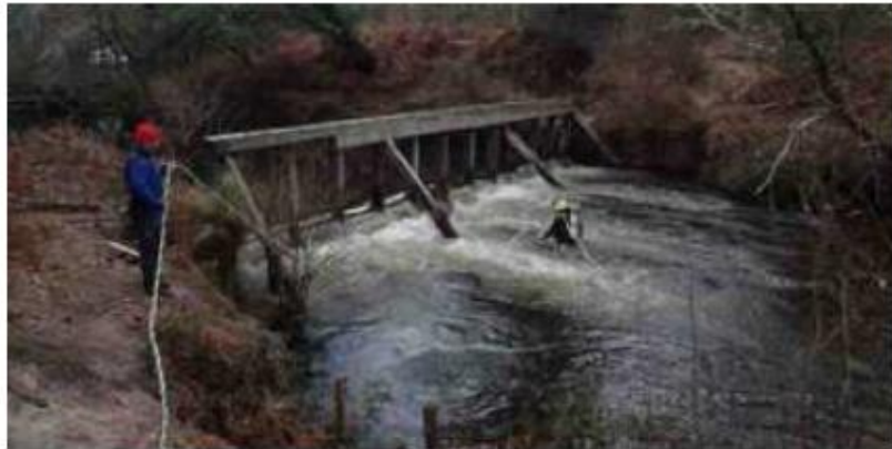
Inspection du barrage par les plongeurs. PHOTO OLIVIER FAVREAU
