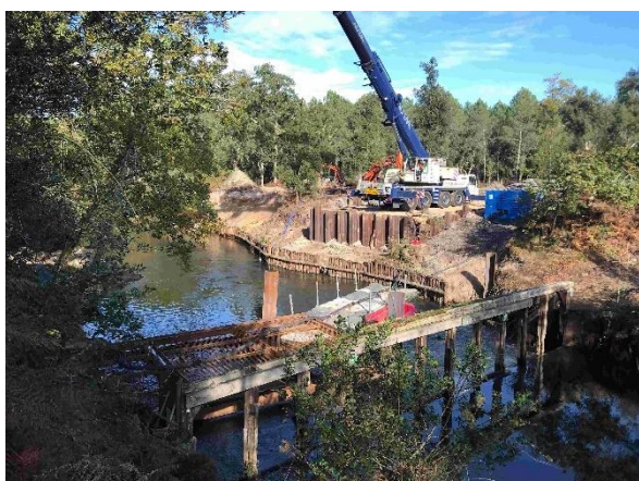
Photo 2 et 3.- Plateforme avec grue mobile en rive droite et travaux dans le caisson étanche en rive gauche
