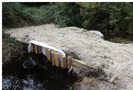
Photo 4.- Réaménagement du seuil de la tourbière (Cout de Mountagne)
