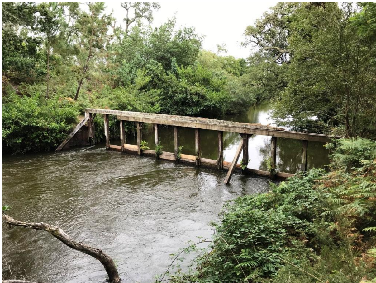
Barrage de la Nasse avant travaux de reconstruction – Photo du 18 août 2021
